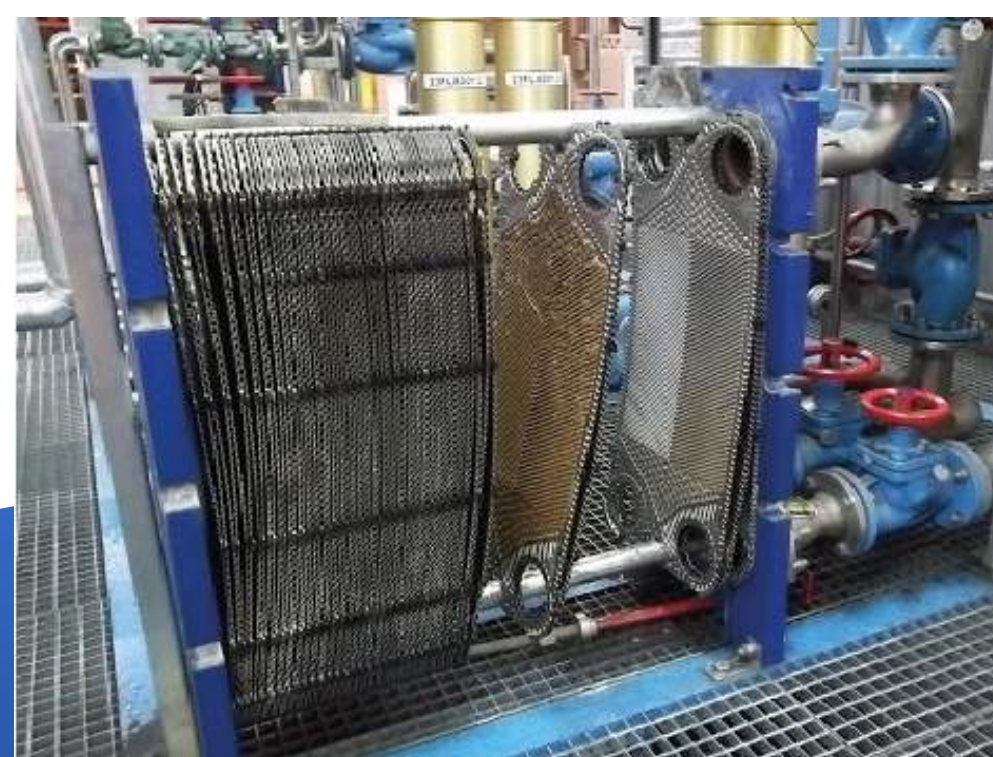
Limpieza y acondicionamiento de placas, reemplazo de sellos con marca original
