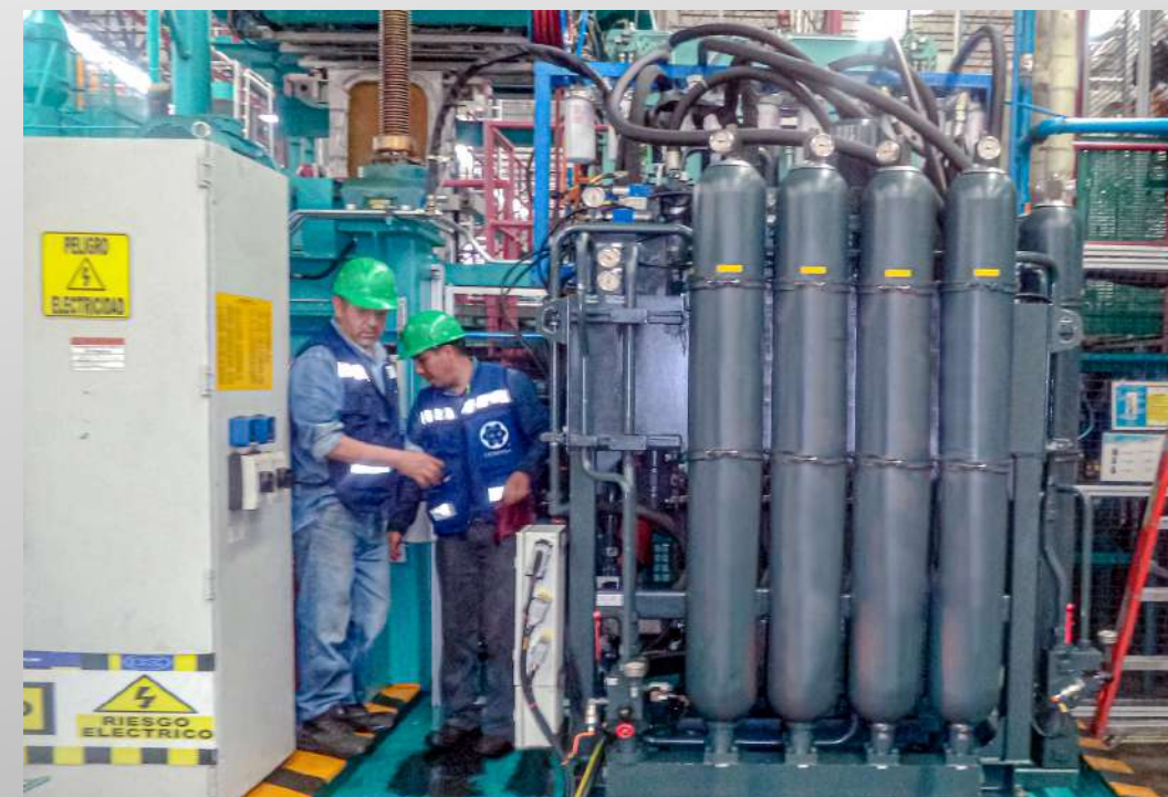
Servicio de mantenimiento y precarga de nitrógeno para acumuladores en máquina inyectora de plástico
