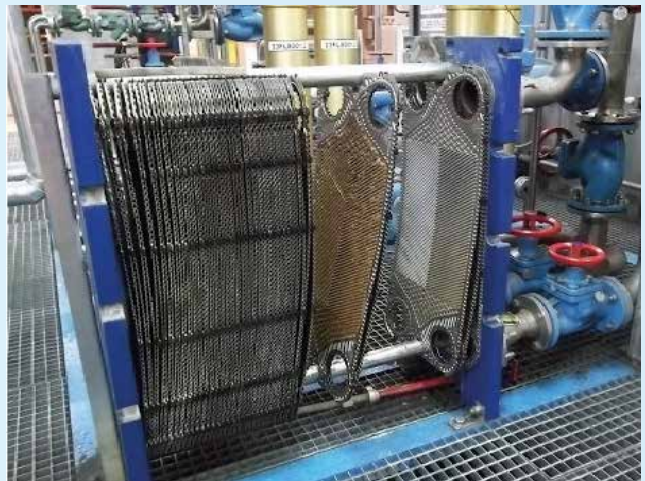
Limpieza y acondicionamiento de placas, reemplazo de sellos con marca original
